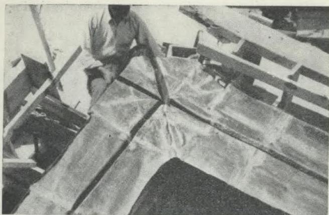
Fig. 5 — Pormenor de um cruzamento de juntas, com a peça especial de ligação de lâminas de cobre já ligada a duas lâminas
