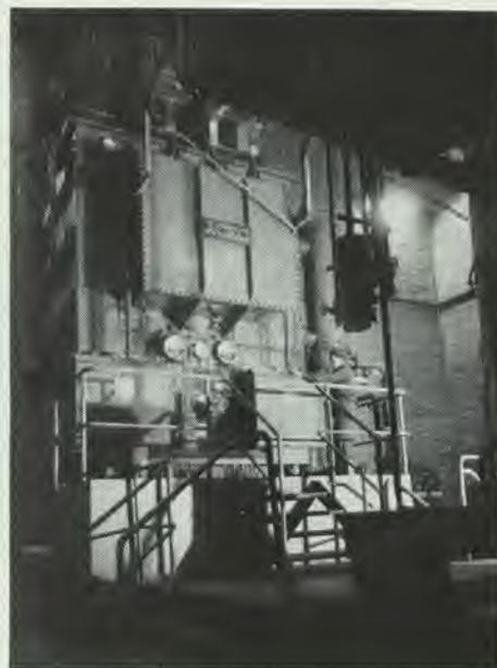
Vista do forno durante a fusão. À direita: Transformador 30 000 kVA - 10 500/483 - 166 Volts alimentando o forno
