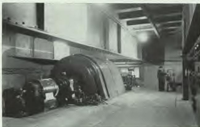
Compensador síncrono de 30 000 kVAR fornecendo a energia reactiva à instalação
