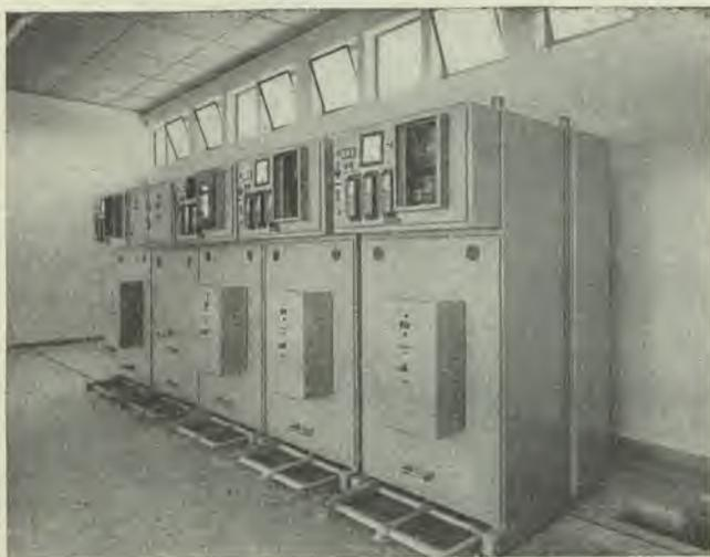
Fig. 9 — Subestação de Portimão — «Normablocos» de 15 kV
