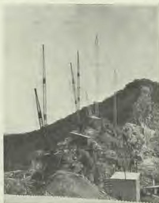
Fig. 10 — Disposição dos derricks de espia ao longo do esporão de quartzite
