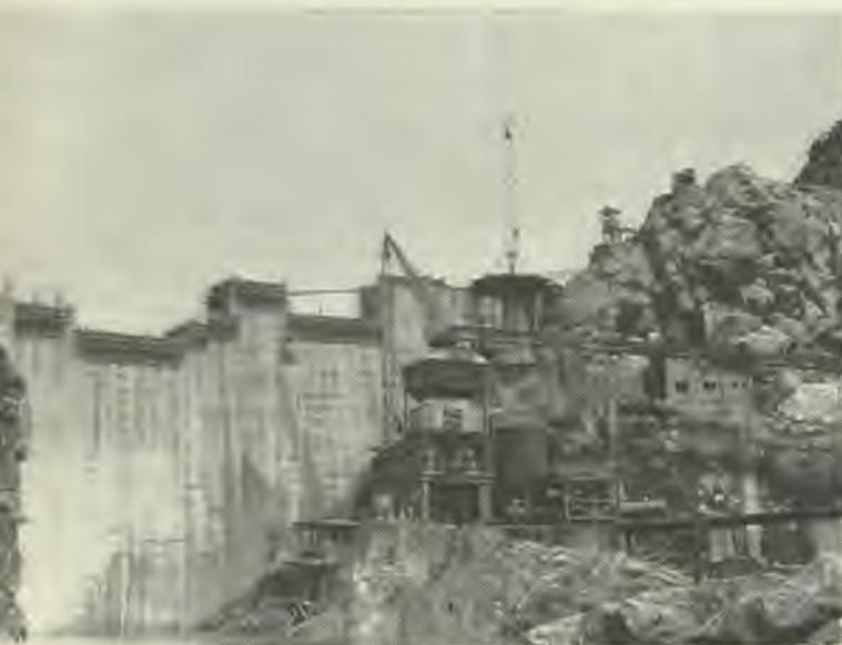
Fig. 9 — Instalação de fabrico de betão
