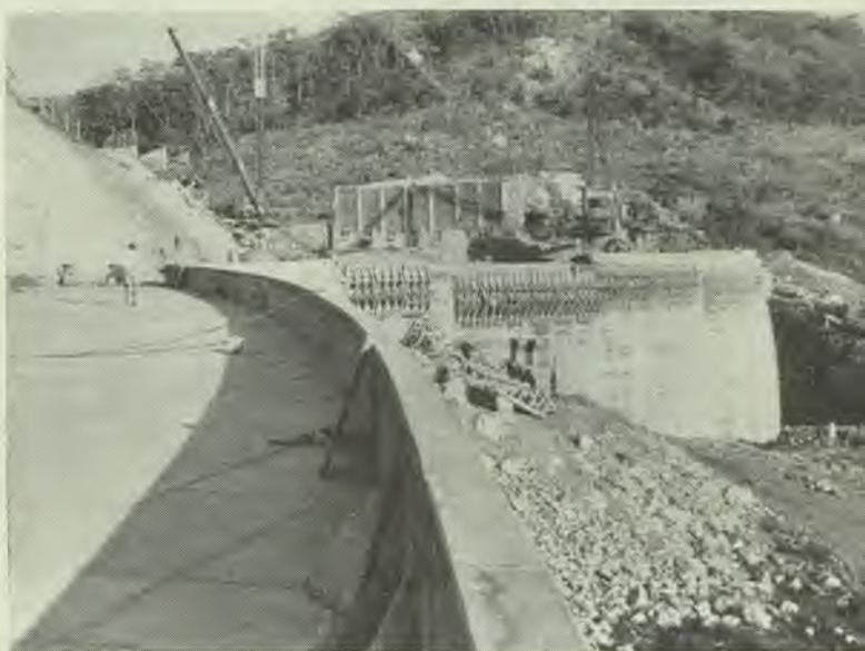
Fig. 6 — Coroamento do arco principal da barragem e vista do arco secundário
