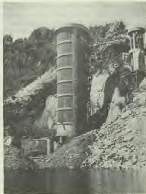
Fig. 3 — Torre de tomada de água
