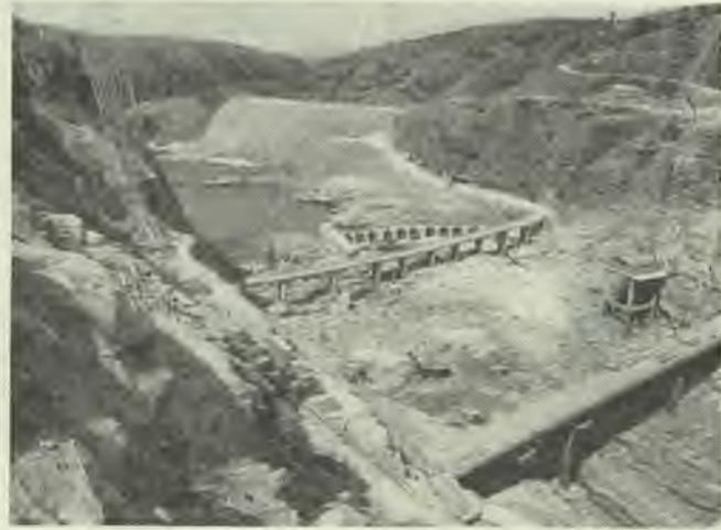
Fig. 40 — Estaleiro da barragem. Enscadeira definitiva, «derricks» e pontes de serviço
