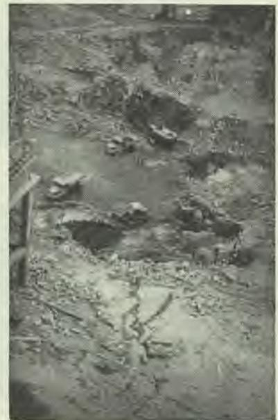
Fig. 41 — Escavação de rochas alteradas da caixa da grande falha, na base da margem direita
