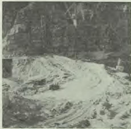
Fig. 46 — Pilar de betão a derrubar para retenção da corrente. Fig. 47 — Pré-enscadeira. Impermeabilização com terras a montante
