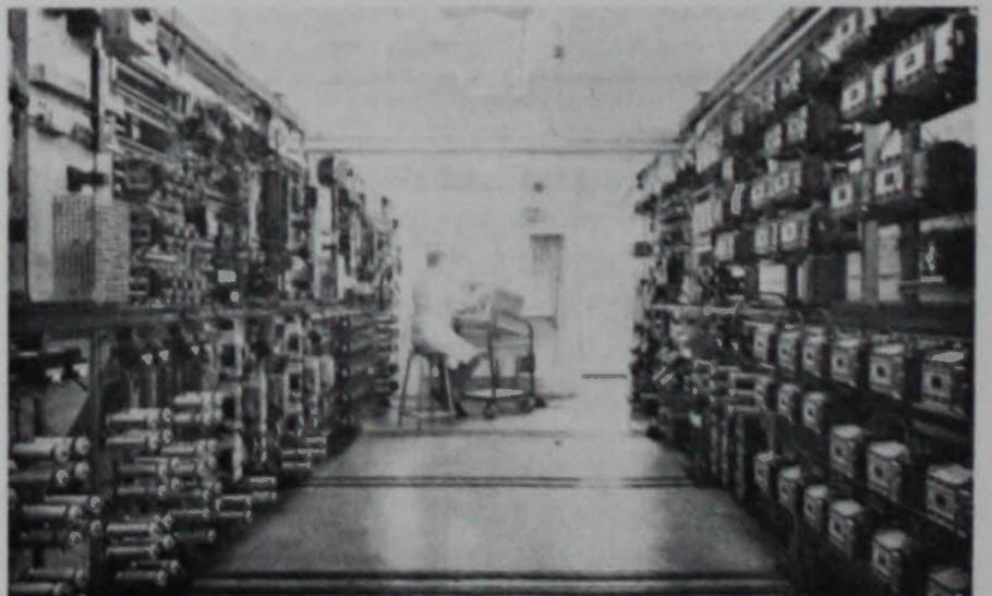
Sala de ensaios do número de manobras dos contactores Telemecanique tipo CN 2
