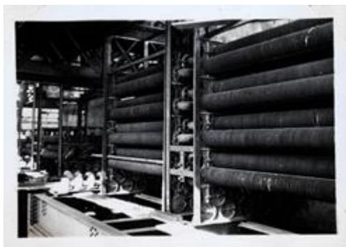
O **sobreaquecedor** estava colocado por baixo das tubagens de retorno do vapor e era constituído por 176 tubos de aço sem costura com o diâmetro de 38 mm mandrilados nas extremidades em colectores fabricados em aço. O
