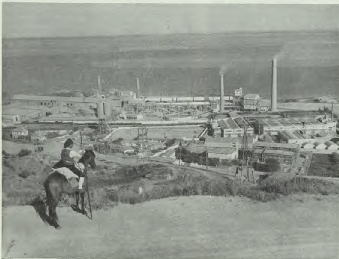
COMPANHIA CIMENTO TEJO — Vista de conjunto da fábrica tirada da zona das pedreiras (Cliché Paris-Match)
