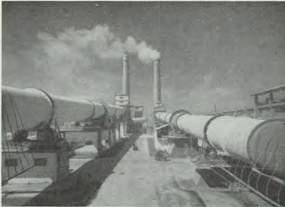
COMPANHIA CIMENTO TEJO — Perspectiva dos fornos e Quadro de comando do forno 5 (Ao fundo da página)
