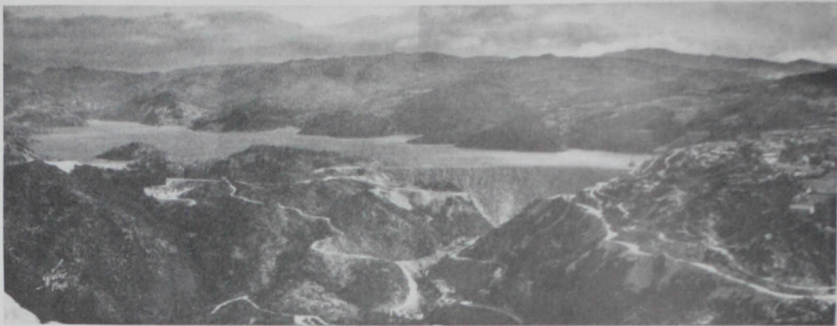
Vista de jusante da barragem e dique da Portela da Telheira (Abril de 1958)
