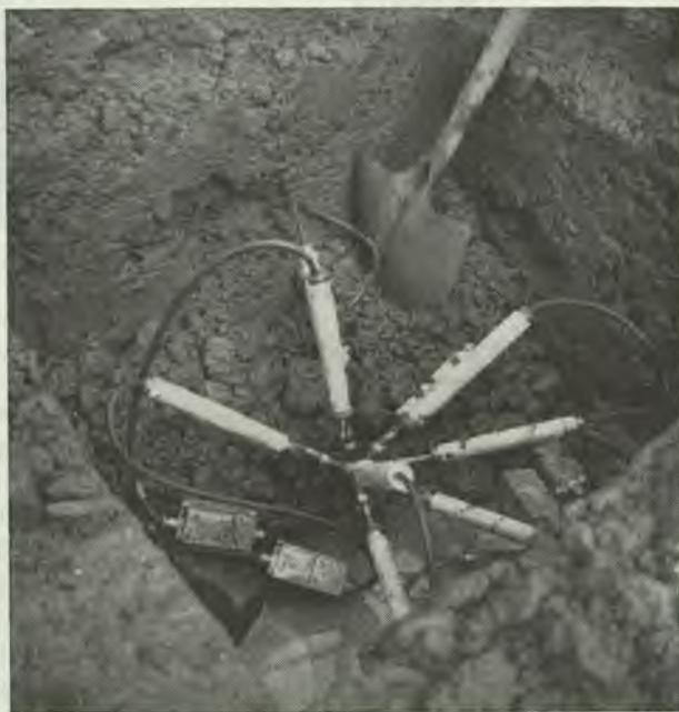
Fig. 23 — Barragem do Cabril — Extensómetros
