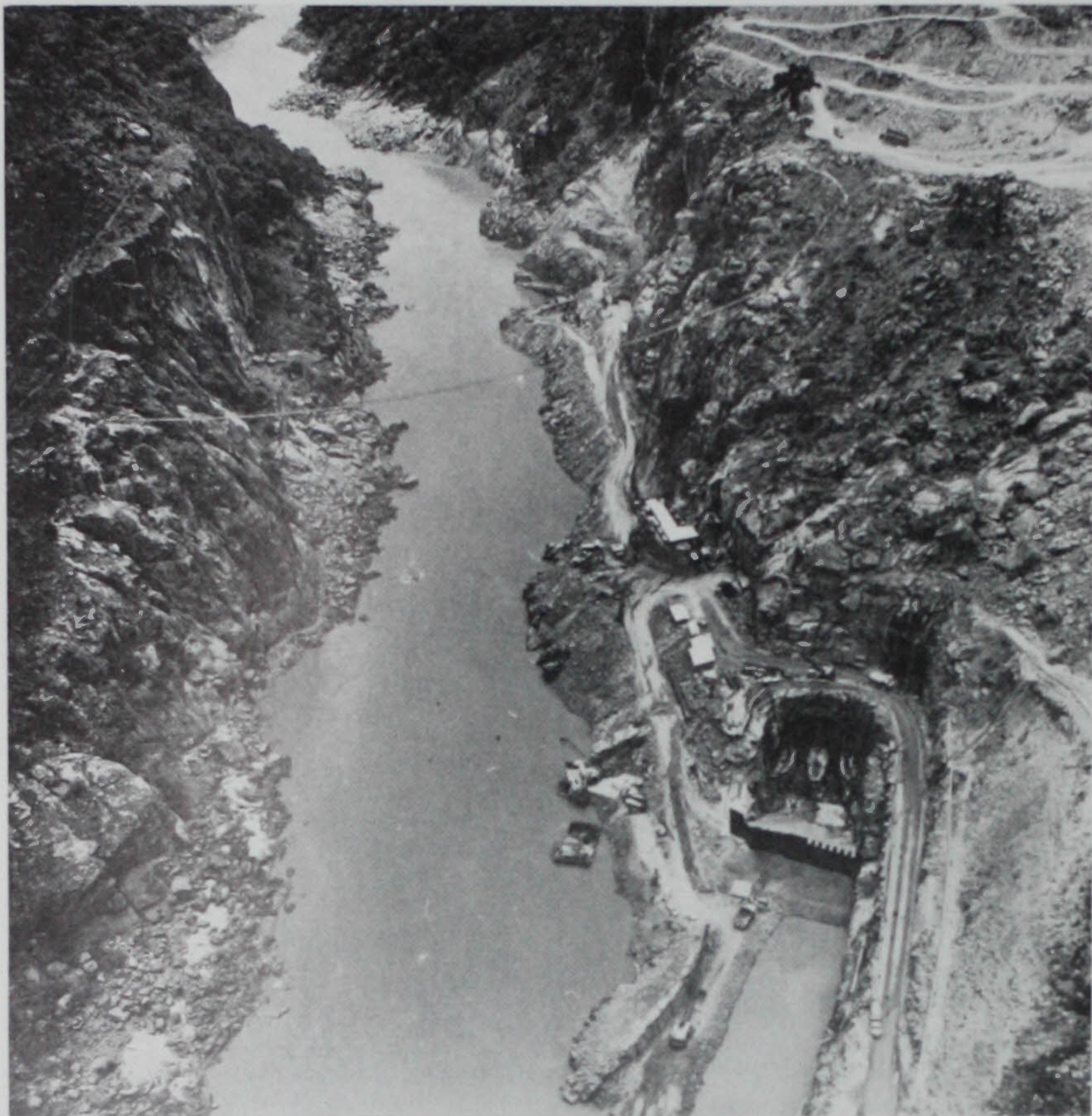
Panorâmica da zona de trabalhos. Vê-se a boca de montante e respectiva ensecadeira provisória, bem como a construção dos hasteais e pilar central. Atravessando o rio a «passerelle» que liga as duas margens.
