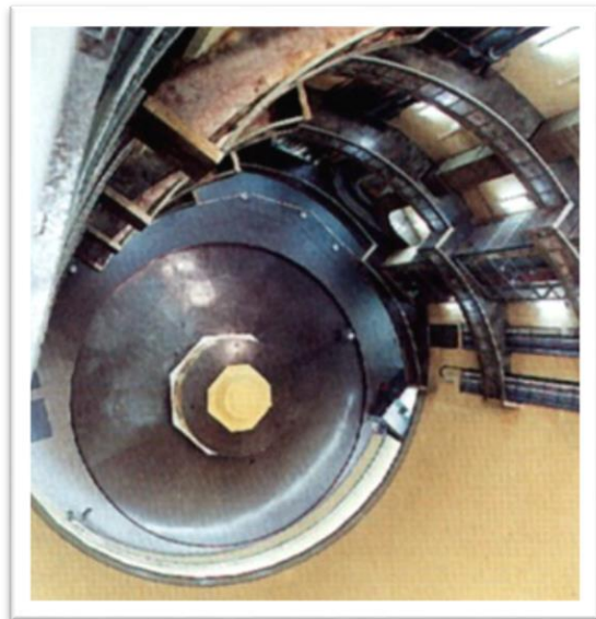
Poço de acesso do grupo I
