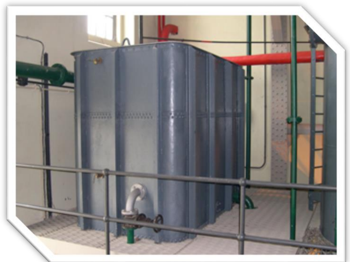
Tanque de água tratada
