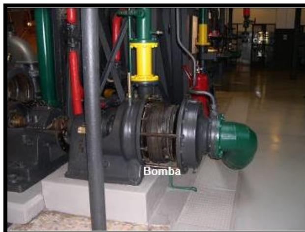
*Bomba de recuperação de condensados*
