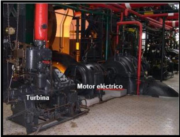
Accionadores da bomba de refrigeração do condensador
