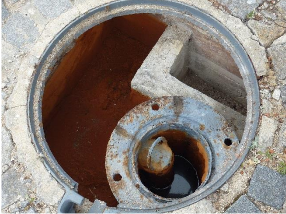
Ensaio no furo artesiano pelo LNEG - Laboratório Nacional de Energia e Geologia no dia 7 de maio de 2013
