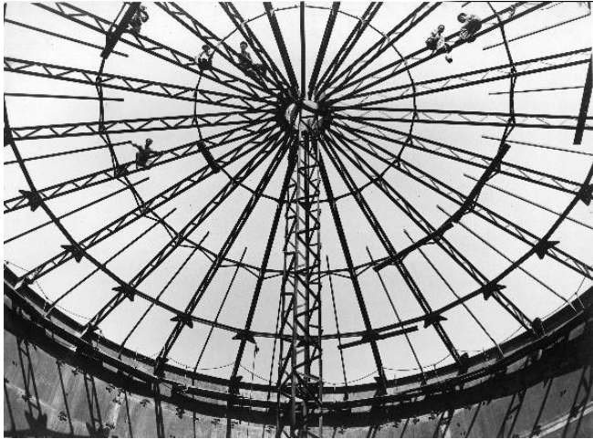
A montagem do depósito de nafta em 1948 e 1949
