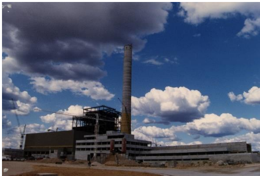
Construção da Central do Pego, 27 de agosto de 1991. (Álbum 12952 _54)
