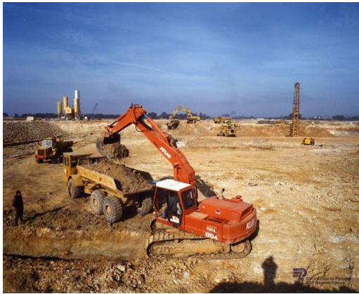
Escavação para os Grupos I e II da Central do Pego. 31 de janeiro de 1989. (Álbum 13227-37)
