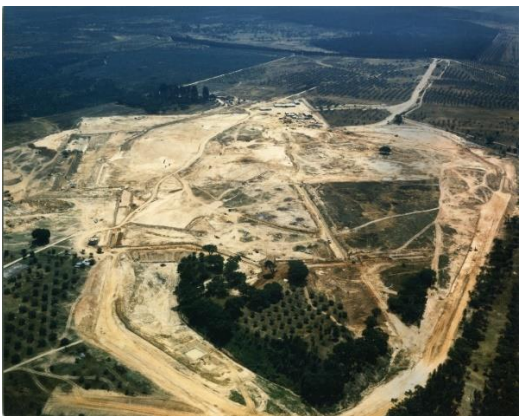
Fotografia da localização da futura Central do Pego realizada pela firma Penaguião & Burnay, Lda., em 11 de Julho de 1988. (Álbum 13227_2)
