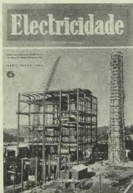
A estrutura metálica representada na capa, é a do edifício destinado à instalação das caldeiras da Central Térmica da Tapada do Outeiro pertencente à Empresa Termoeléctrica Portuguesa que foi construída e montada pela
