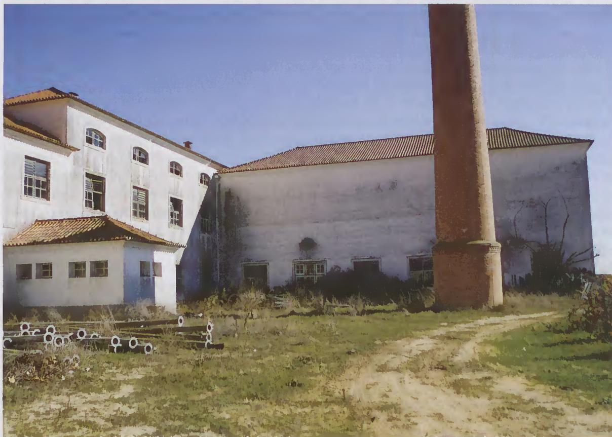
Fig. 17 - *Fábrica de Descasque de Arroz de Muge. Tardoz. Edifício da Central Termoelétrica. 2008. Fotografia do autor. Repare-se na localização separada da chaminé fabril e a concepção do piso superior sem fenestração, adequado para ensilagem.*
